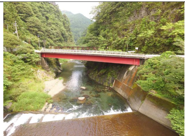
新角屋橋(鋼桁橋)
