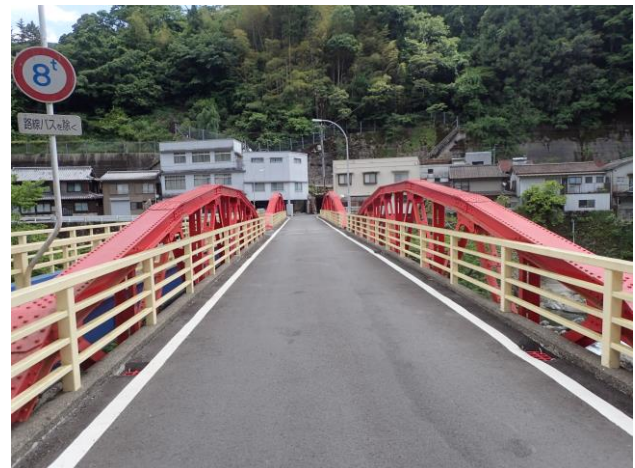
落合橋(1933 年竣工)
