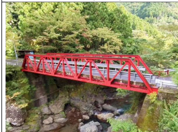
大北橋(鋼製トラス橋)
