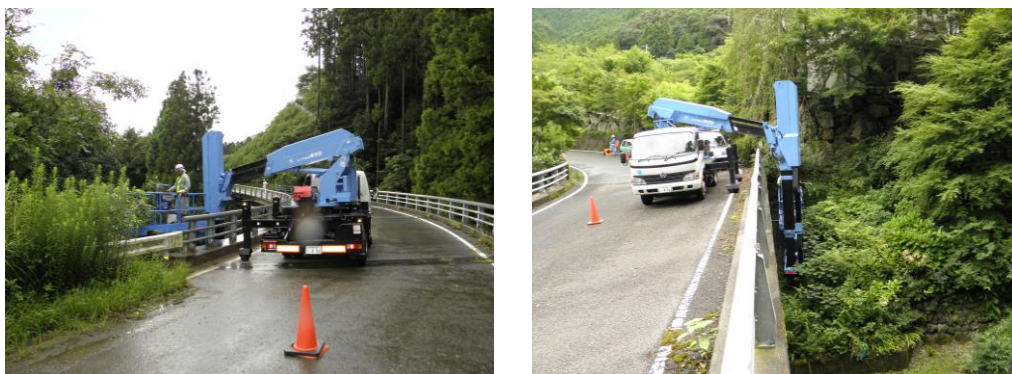
写真2 H24年度橋梁点検状況（橋梁点検車使用）
