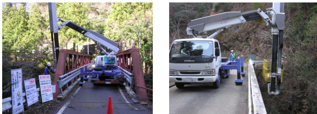
写真2 H20年度橋梁点検状況（橋梁点検車使用）
