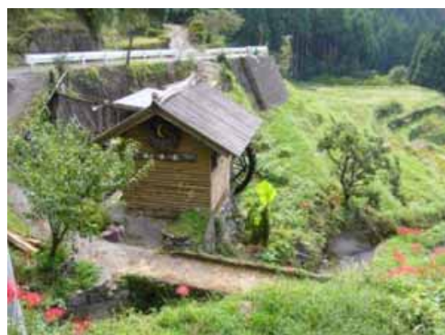
写真 2-17 平成の水車小屋
