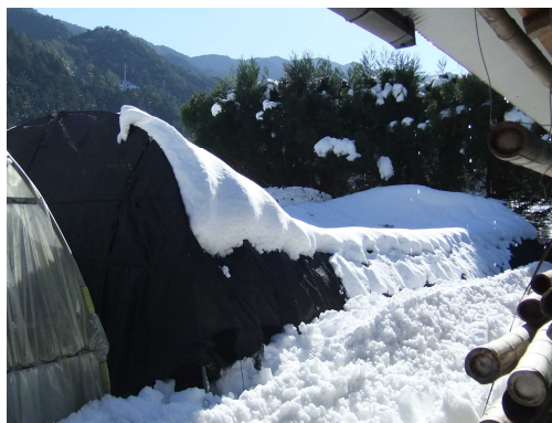
ビニールハウスの損壊
