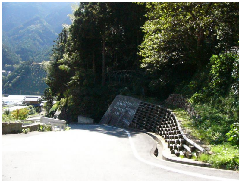
木製の擁壁（田野々地区）
