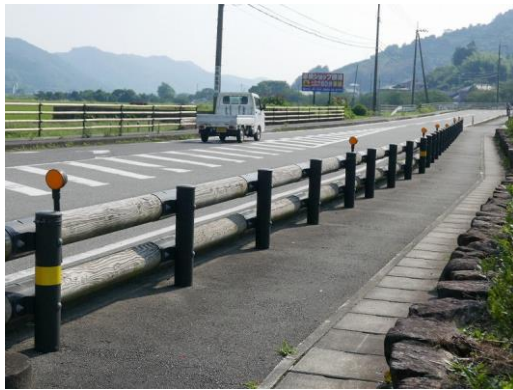
木製のガードレールと防護柵 （勝浦町）
