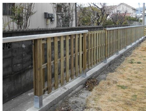
ブロック塀の崩壊対策として期待される木製の塀（徳島県内）
