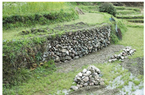
石積みによる復旧（檜原地区）
