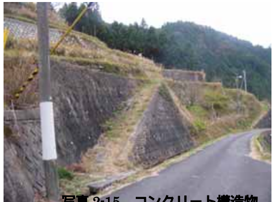
写真 2-15 コンクリート構造物
