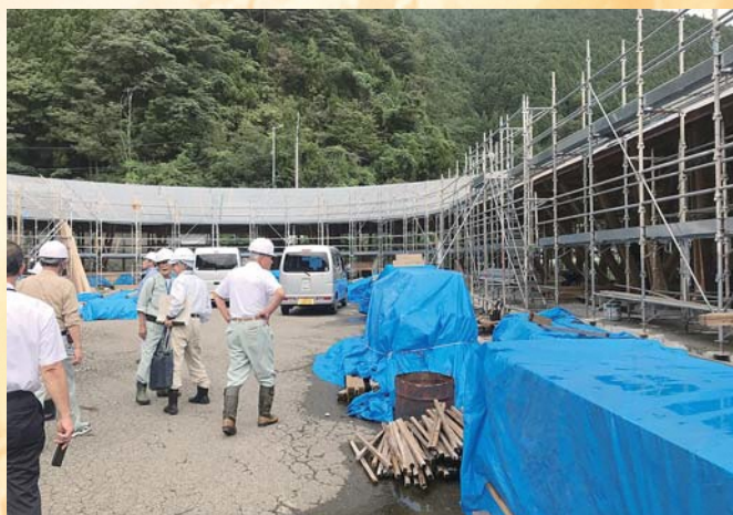
新ごみステーション建築現場
