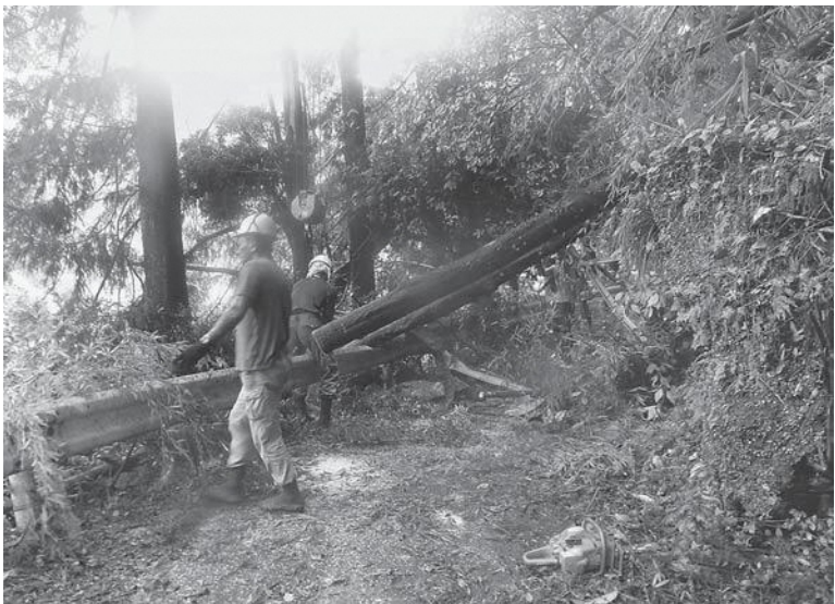
災害による倒木撤去作業
