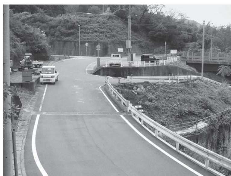
高鉾公民館入口の改良現場
