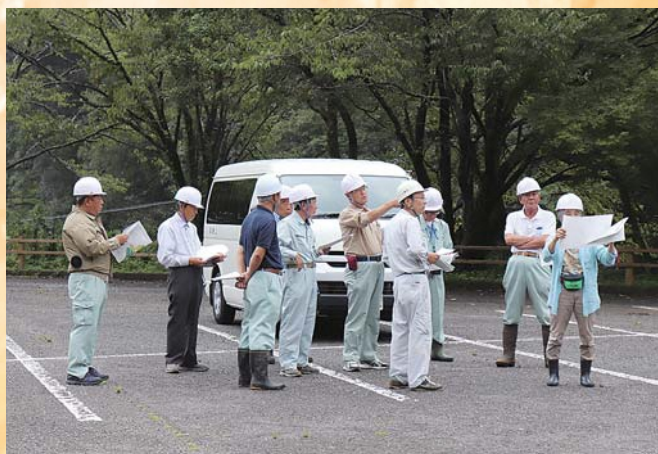
福川グラウンド拡張工事現場
