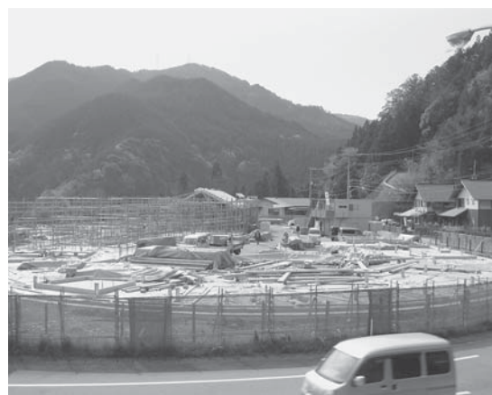
ごみセンター新設工事状況（2019.4）
