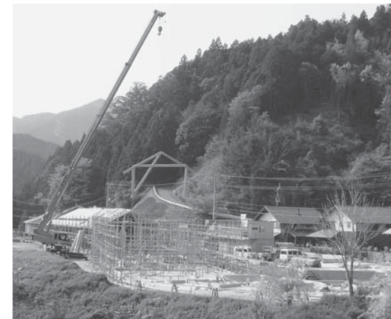
ごみセンター新築工事状況
