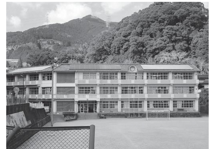
太陽光発電が整備されている (上勝小学校)
