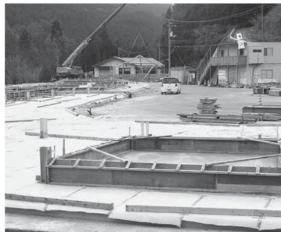
新ごみセンター建設状況（基礎ができた） 1月21日
