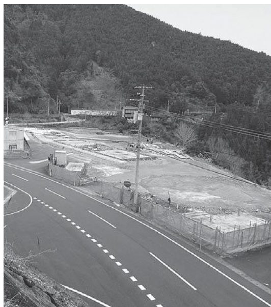
建設中の新ごみステーション
