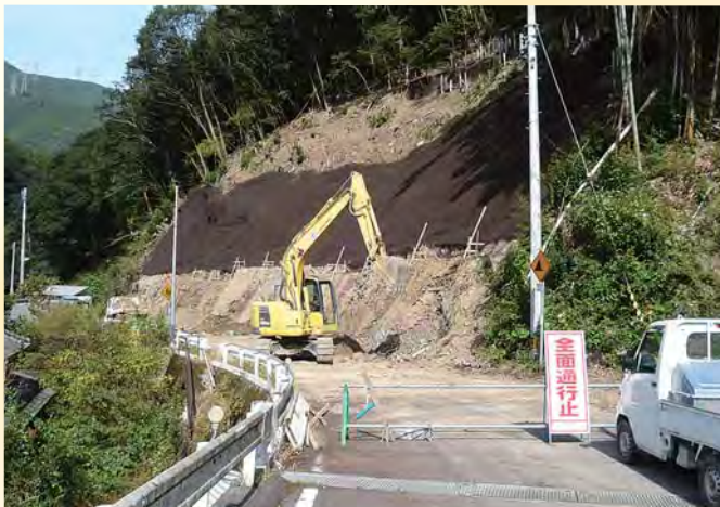
完成間近な福川福原線改良工事 (正木)
