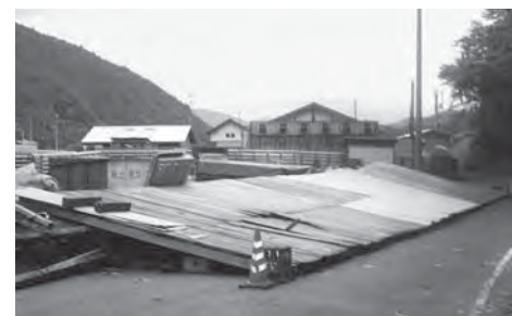
倒壊したステーションの屋根
