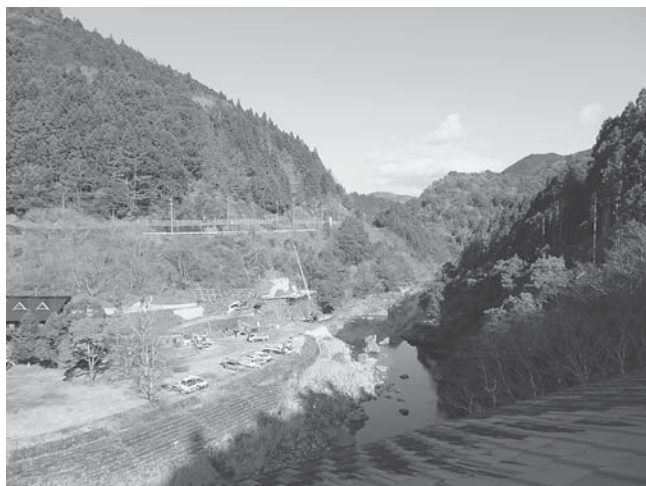
工事が進む仮称いろどり橋
