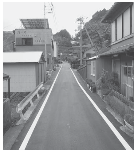
蘇った町道（藤川・傍示線）
