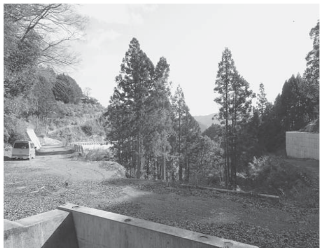
広域農道1-2工区（正木西中地区）
