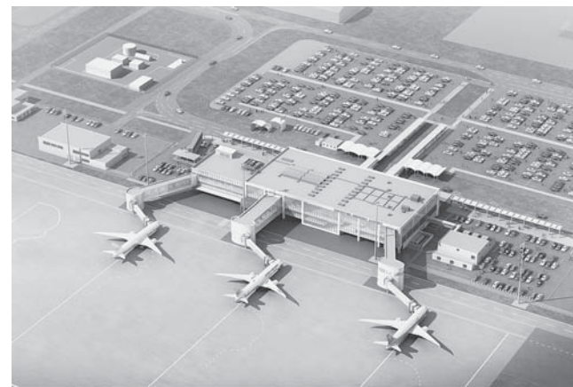
徳島阿波おどり空港の国際空港化は、税関や動植物検疫室、出入国審査場など必要な設備を完備し、3基目となる搭乗橋を備えて工事が完了した。
