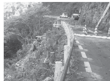
瀬津野尻線改良工事
