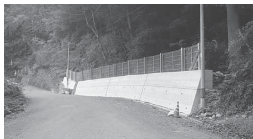
6月に要望し早期完成した町道槻地線防護ネット
