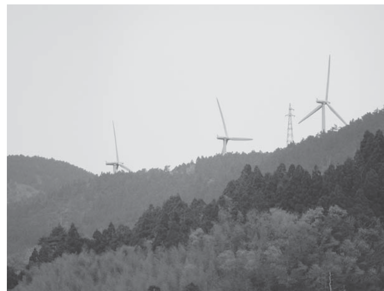
町界にある風力発電機
