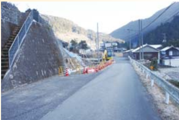
旭中村県道改修工事
