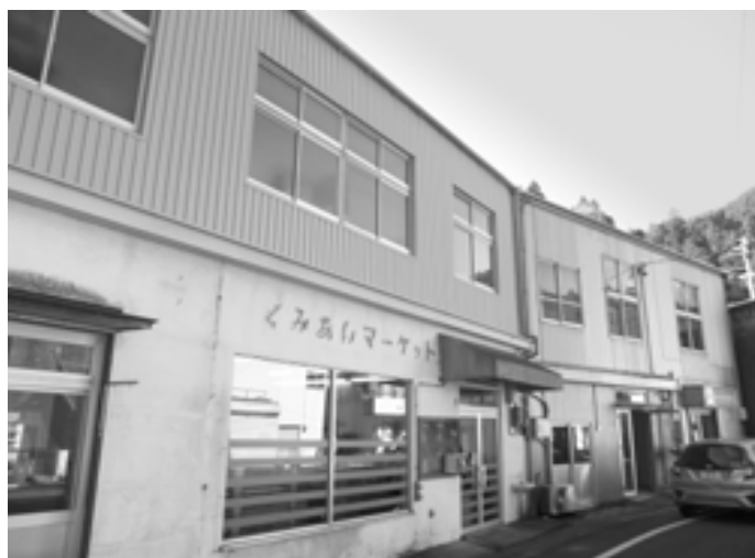
改修される旧JA福原事務所
