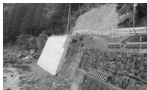
災害復旧工事完了現場（市宇）
