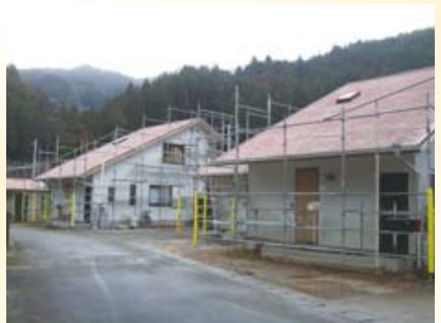
喰田住宅改修中
