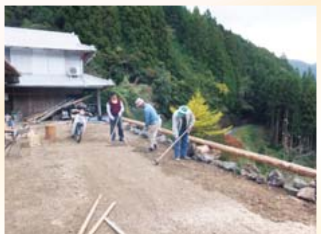
棚田村空家改修
