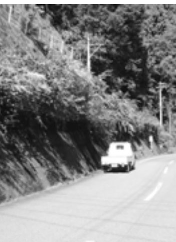
草木が覆い被さる県道
