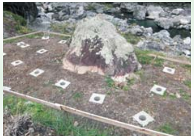
建設中の大北アート
