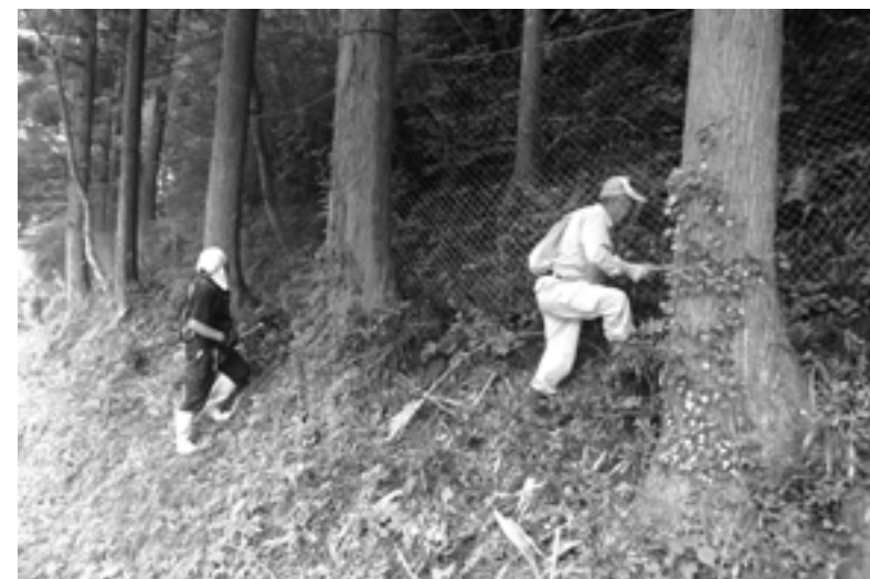
有害獣防護ネットの点検（府殿）
