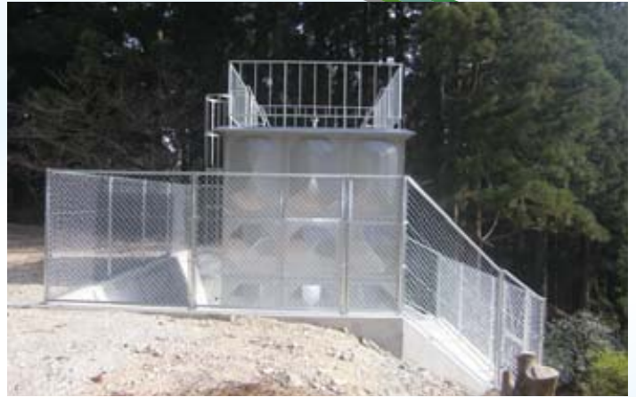
完成した府殿簡易水道
