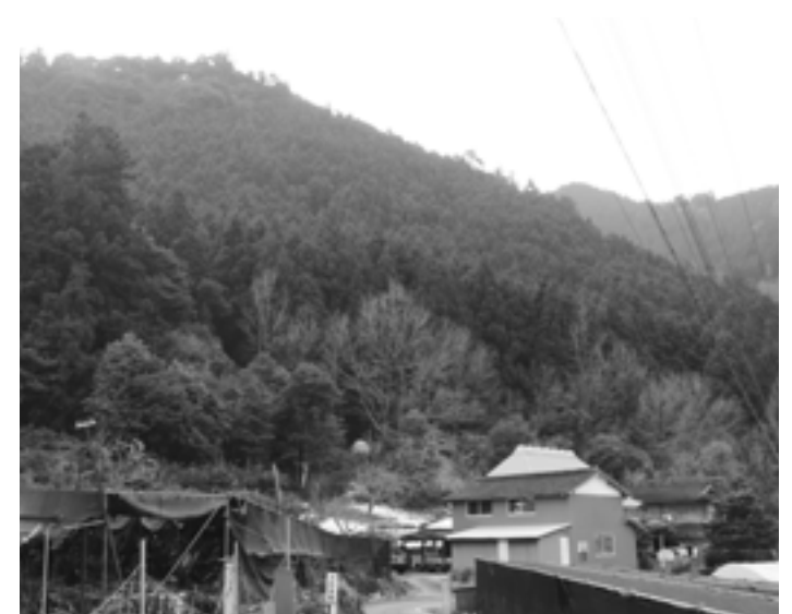
裏山の崩壊対策は
