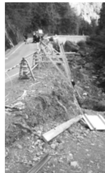
進む県道改良工事（市宇）
