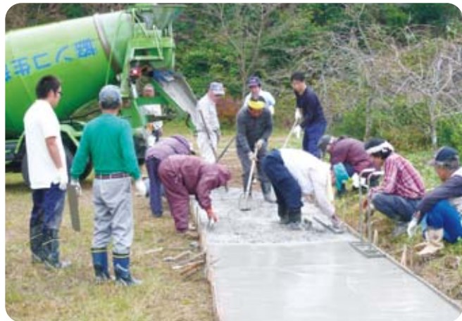
彩公園歩道舗装工事（正木）
