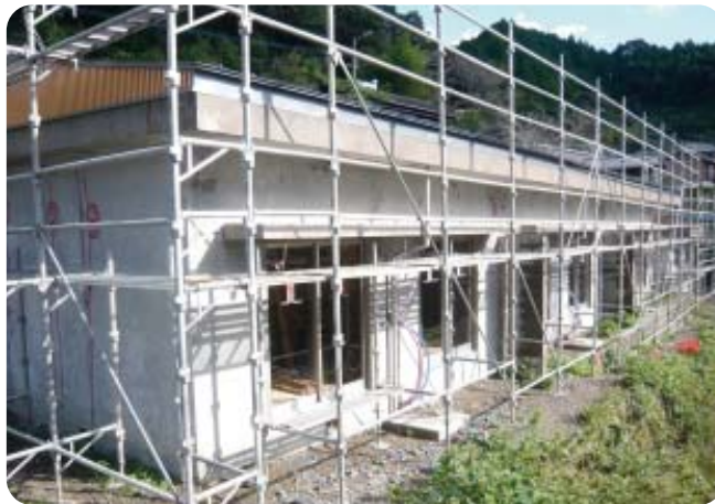
旧教員宿舎改築工事（正木）
