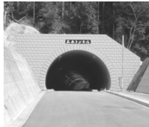
正木トンネル（藤川側）
