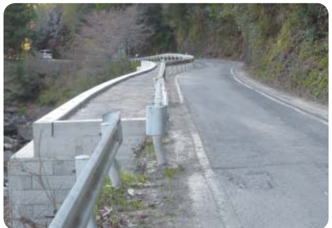
徳島上那賀線改良工事（市宇）
