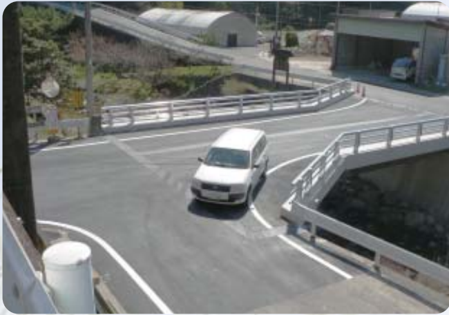
南岡橋改良工事（正木）
