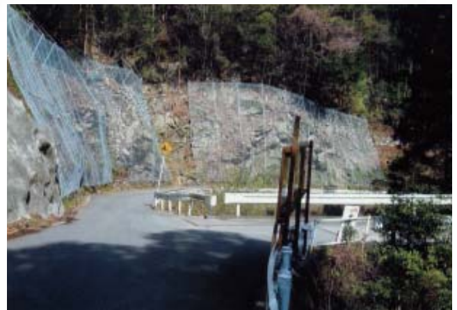
落石防止網設置工事（福原）
