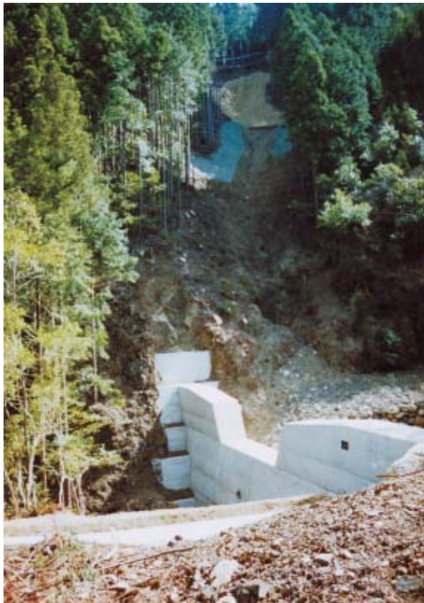
治山工事（杉地）
