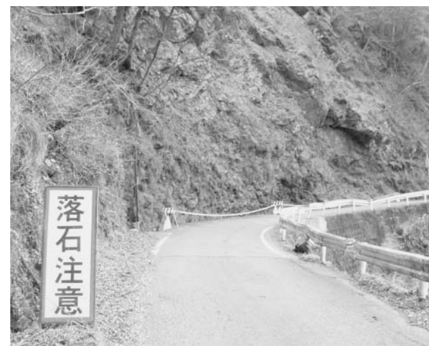
町道剣山線災害復旧工事箇所(谷口)
