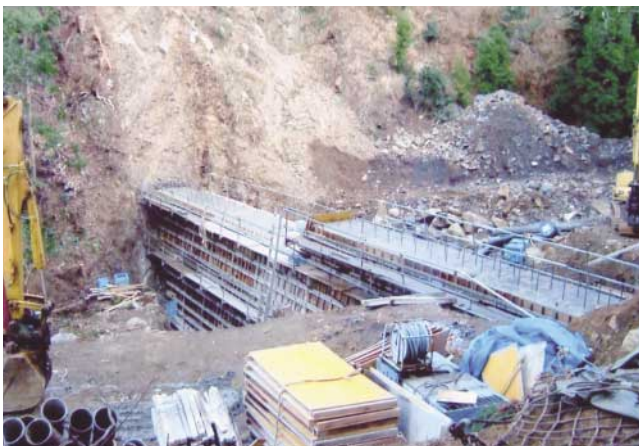
治山工事（杉地）
