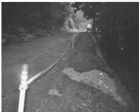
湖南線地盤沈下による陥没状況
