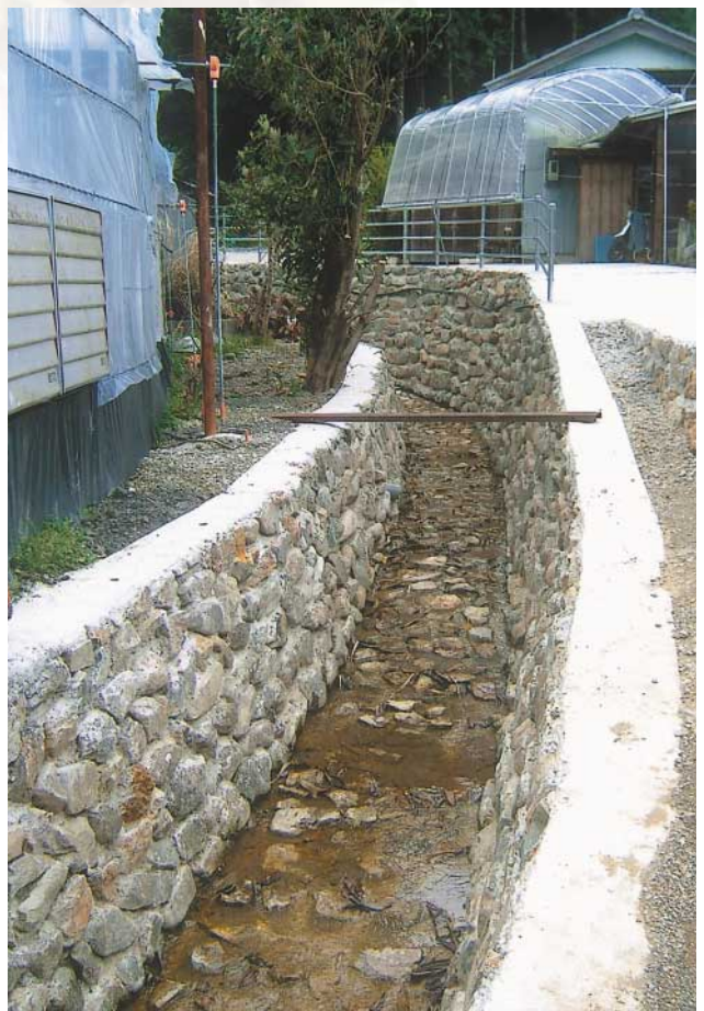
河川災害復旧工事（福川）
