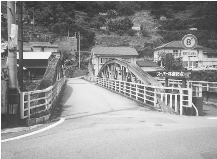
改修される落合橋
