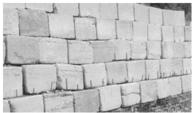
杉地線の産廃コンクリートブロック
