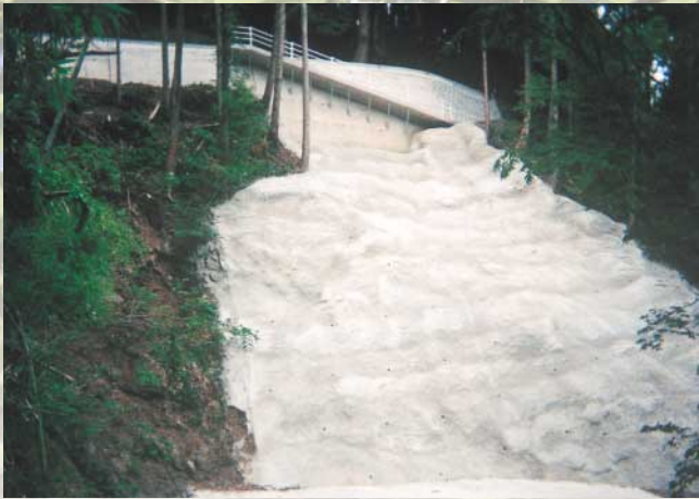
野尻用水災害復旧工事（野尻）
