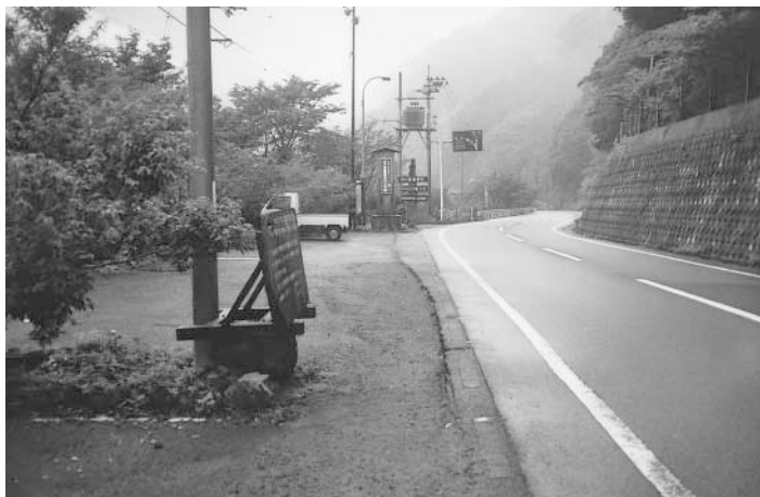
キャンプ場上の駐車場の沈下による段差
