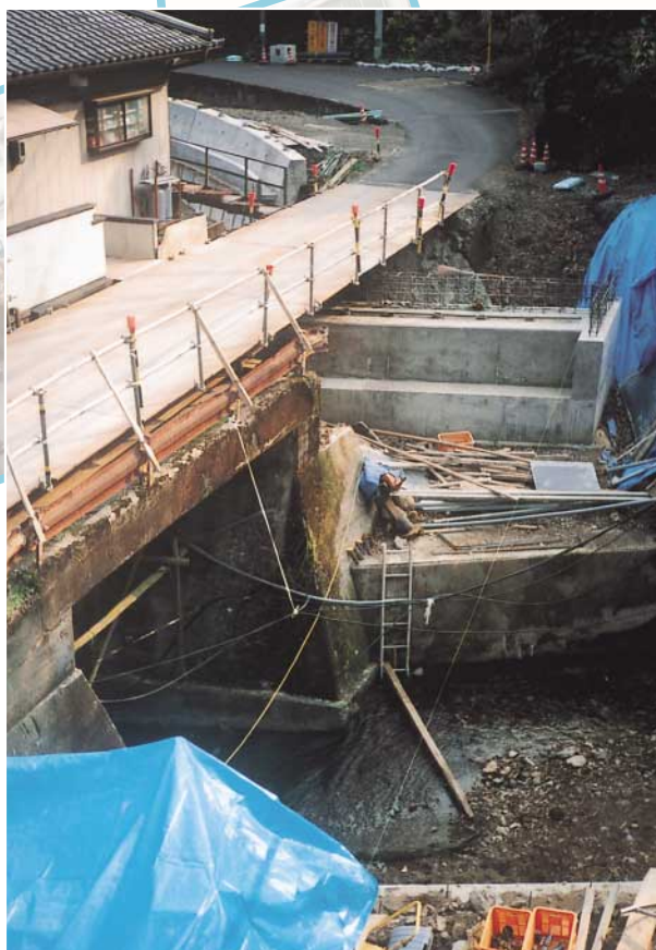
桃の花橋掛替工事（傍示）
