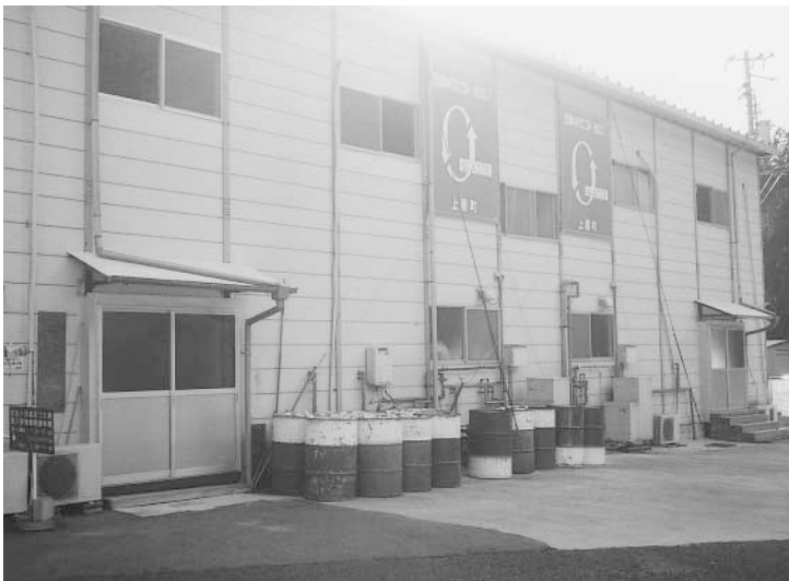
日比ヶ谷ゴミステーション
