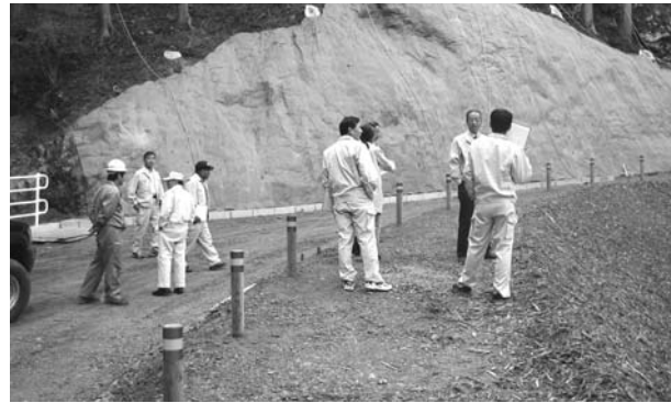
森林基幹道生実八重地線(生実工区)
