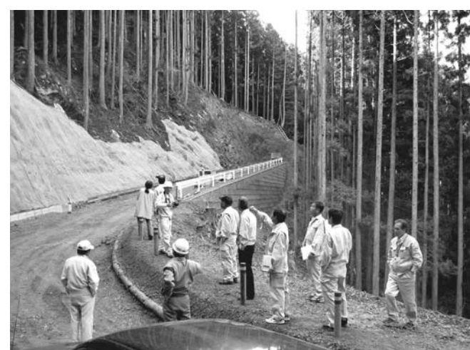
森林基幹道生実八重地線（生実工区）
