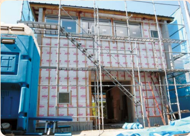
藤川分団詰所建替工事中
