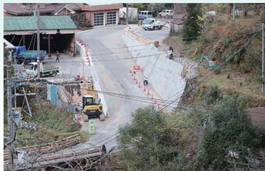
湖南線拡幅工事
