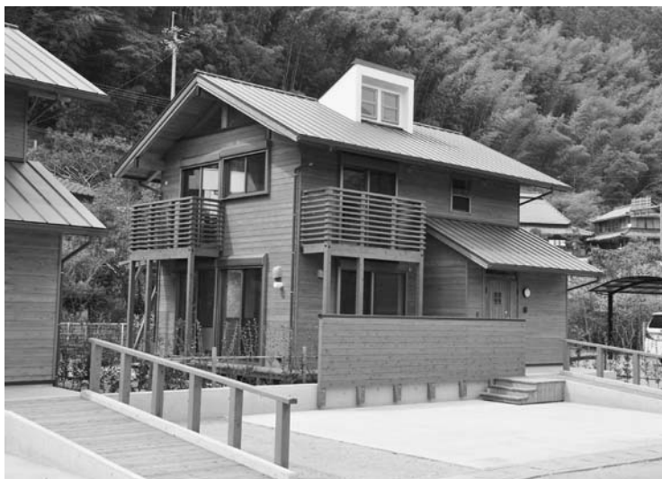
福川町営住宅新築工事
