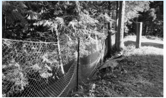
防護柵設置事業
