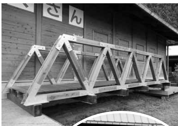
▲昨年度開発した組立式歩道橋。防腐処理で長寿命化。
