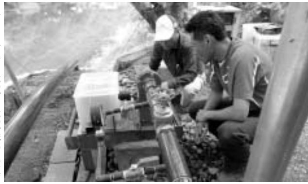
▶福川小水力発電 発電機の写真
