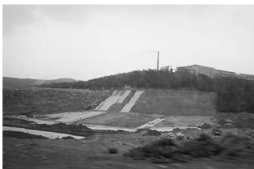
3/1 ゴミ埋め立て最終処分場（徳陽市）
